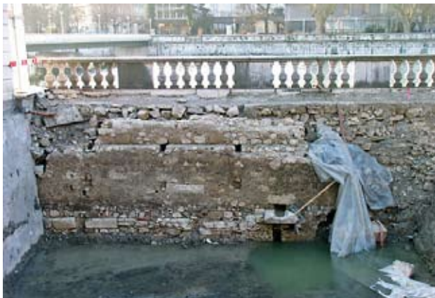
Jüngere Mauer, dahinter die Ufermauer des Palaisgartens
